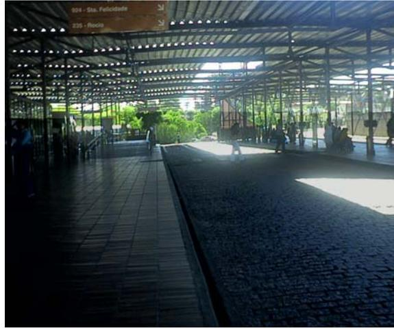
**Figura 6.12** – Pavimento com paralelepípedos dentro do terminal
