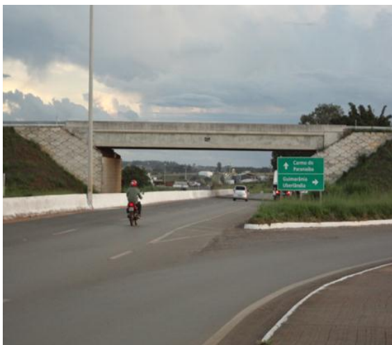
Figura 72: Viaduto "Jairo Nogueira" – BR 354
