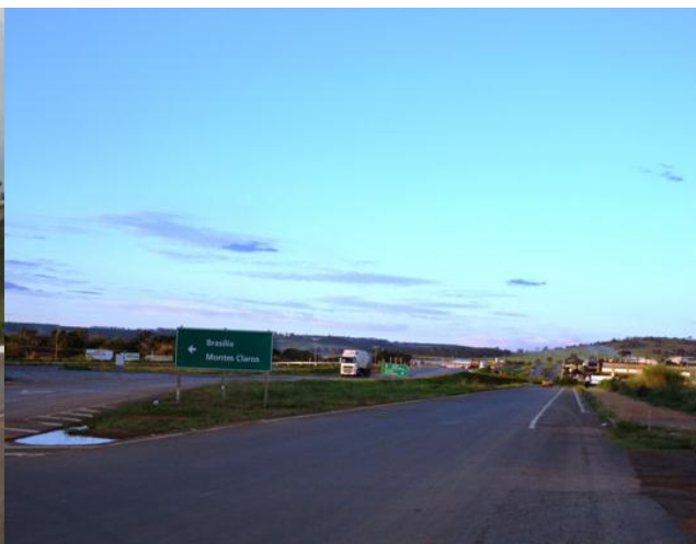
Figura 73: Viaduto "Jairo Nogueira" – BR 365
