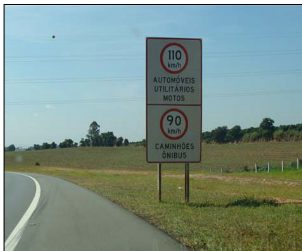
Figura 2.4 - Falta de suportes colapsíveis
