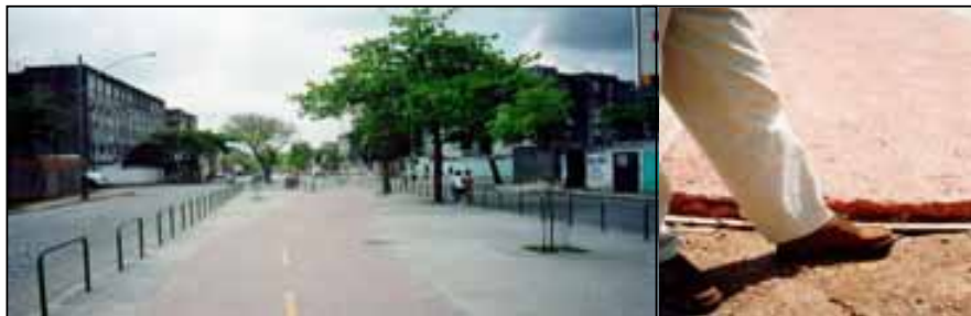
Figura 3.7 – Pavimento colorizado com oxalato de ferro em ciclovias de Bangu e Campo Grande/ Rio de Janeiro (GEIPOT, 2001)
