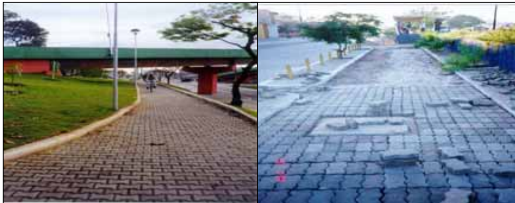
Figura 3.11 – Pavimentos de ciclovias com Blocos Pré-Moldados em Volta Redonda/RJ e Teresina/PI (GEIPOT, 2001)
