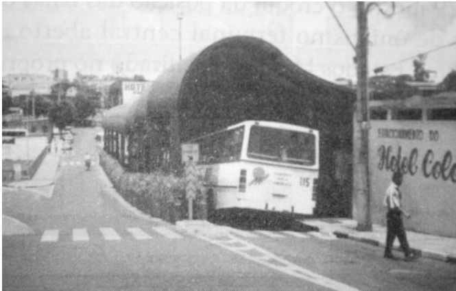
Figura 3.5: Terminal central fechado de Araraquara, Brasil (vista externa) Fonte: Ferraz e Torres (2004)
