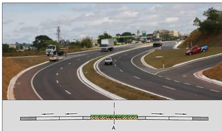
Figura 2.4 – Rodovias de múltiplas faixas suburbana dividida
