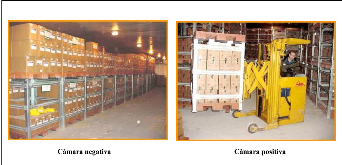
Figura 4.16: Câmaras de Armazenagem do Depósito Central da cadeia de frio do Programa Nacional de Imunização Fonte: Ministério da Saúde (2006)
